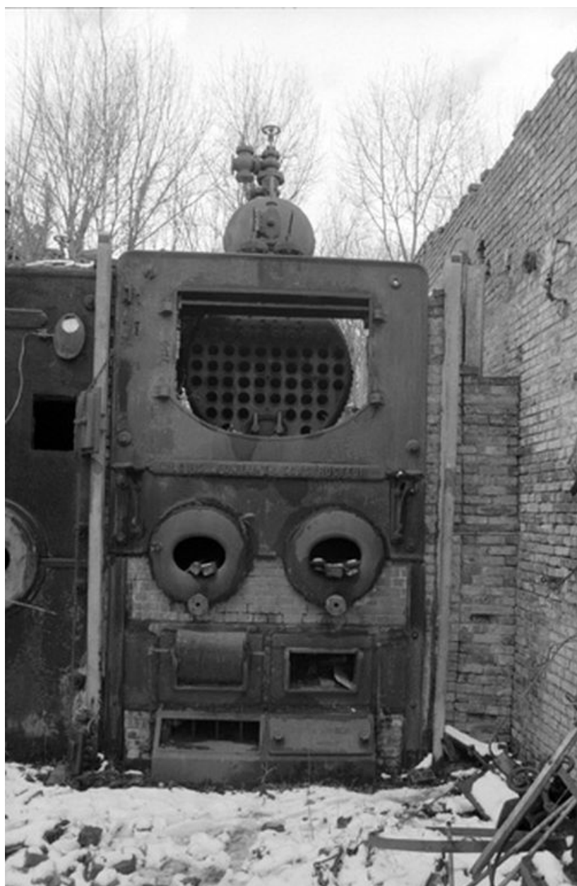
Chaufferie, chaudières à vapeur (constructeur Louis Fontaine).
