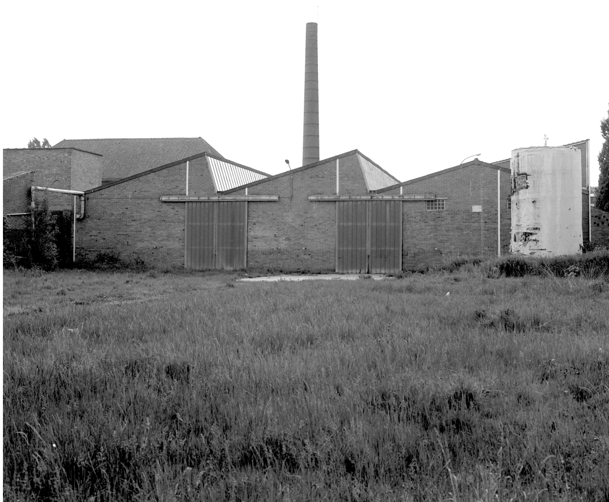
Atelier de fabrication, élévation avenue Aristide-Briand.
