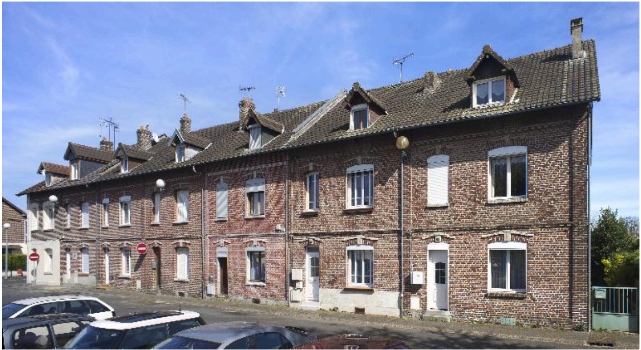
Vue des logements situés à l'est de la place de la Raffinerie (2 à 14 place de la Raffinerie), depuis le sud-ouest.
