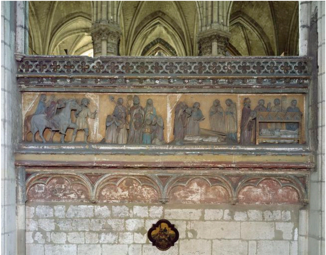
Vue de la deuxième travée nord.
