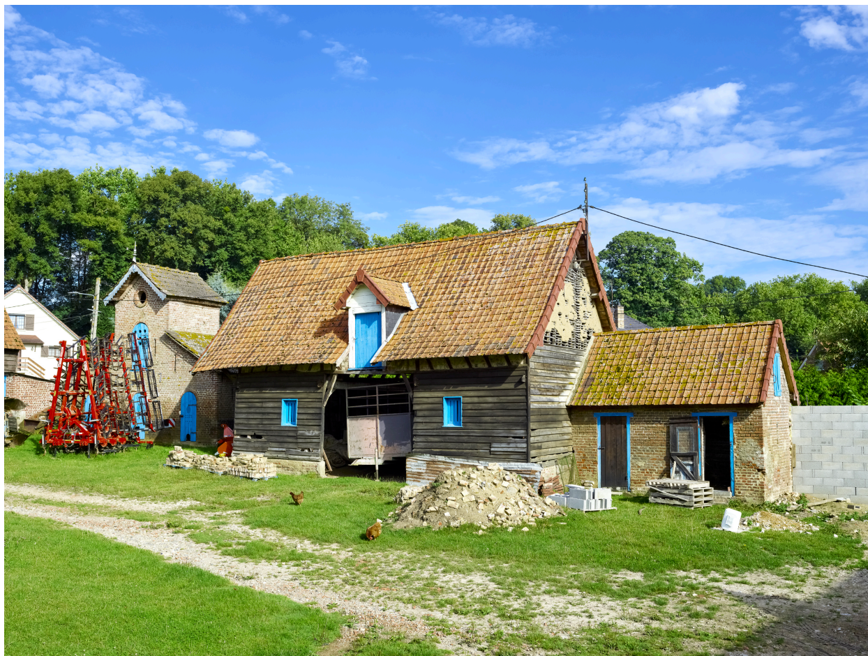
Vue de la bergerie, depuis le sud-est.
