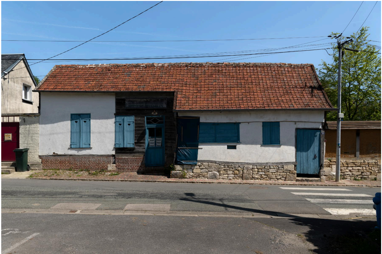
Maison de serger, n°15 de la rue des Jardins, vue prise depuis l'ouest.
