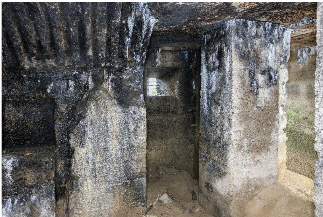
Créneau de fusillade nord vers le couloir
