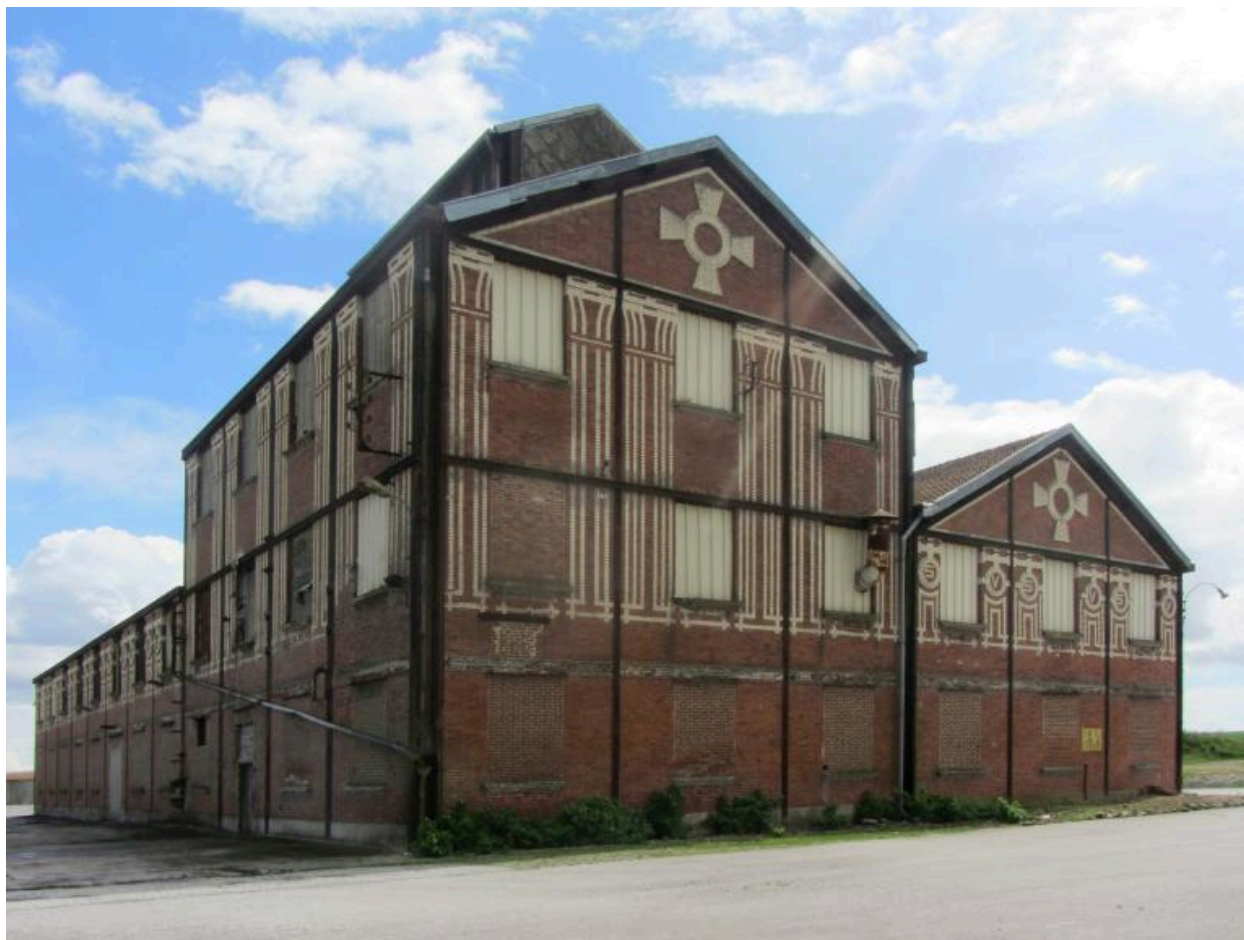
Vue d'ensemble nord-ouest de la râperie.
