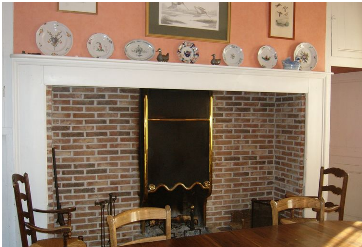
Vue d'une cheminée traditionnelle munie d'un foyer à la prussienne de forme différente.
