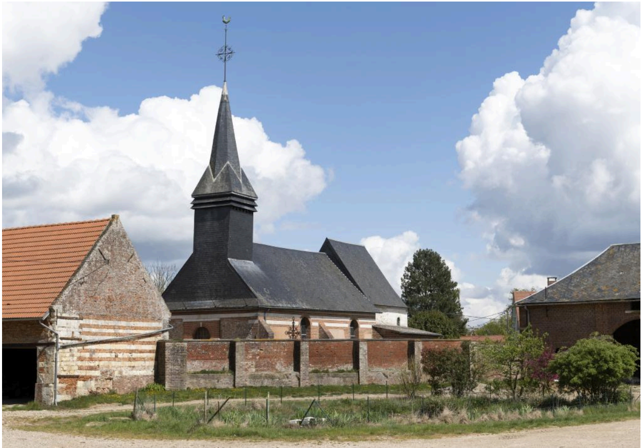
Cour de la ferme du château, ancienne mare et église en second plan, vue depuis le sud-ouest.
