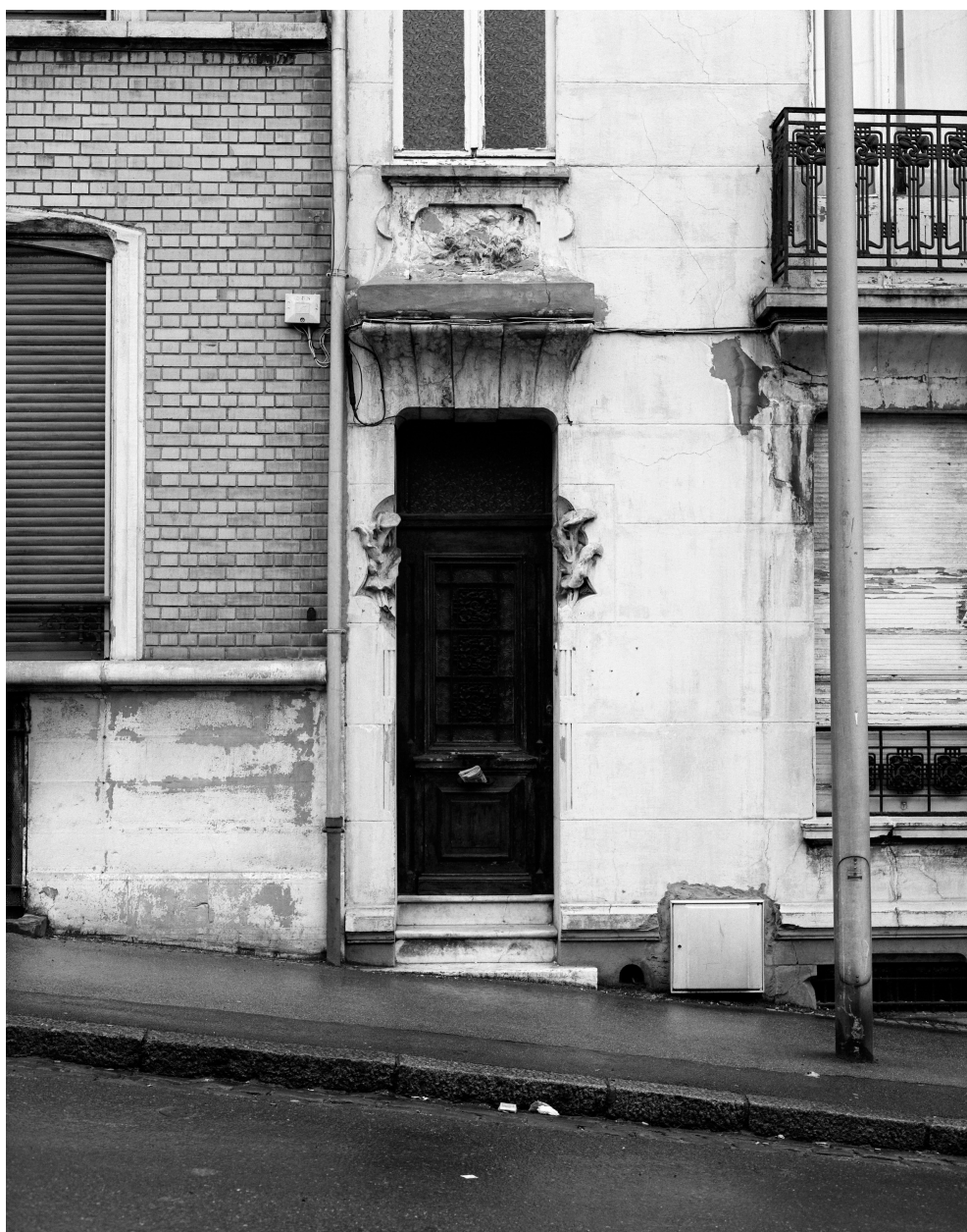
Façade sur voie, porte.
