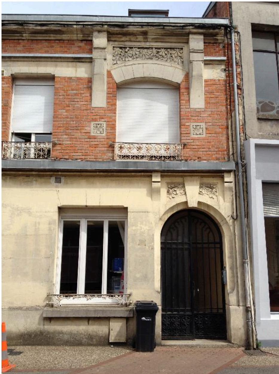
Ancienne boucherie Chevreux, 13 rue du Général-Foy, G. Renaud (architecte), O. Enfant et Rassart (entrepreneur), 1921. Détail de la partie droite.
