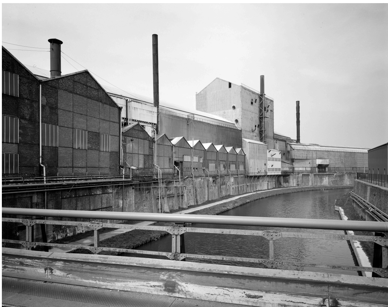
Vue générale des anciens laminoirs depuis le pont traversant l'usine.
