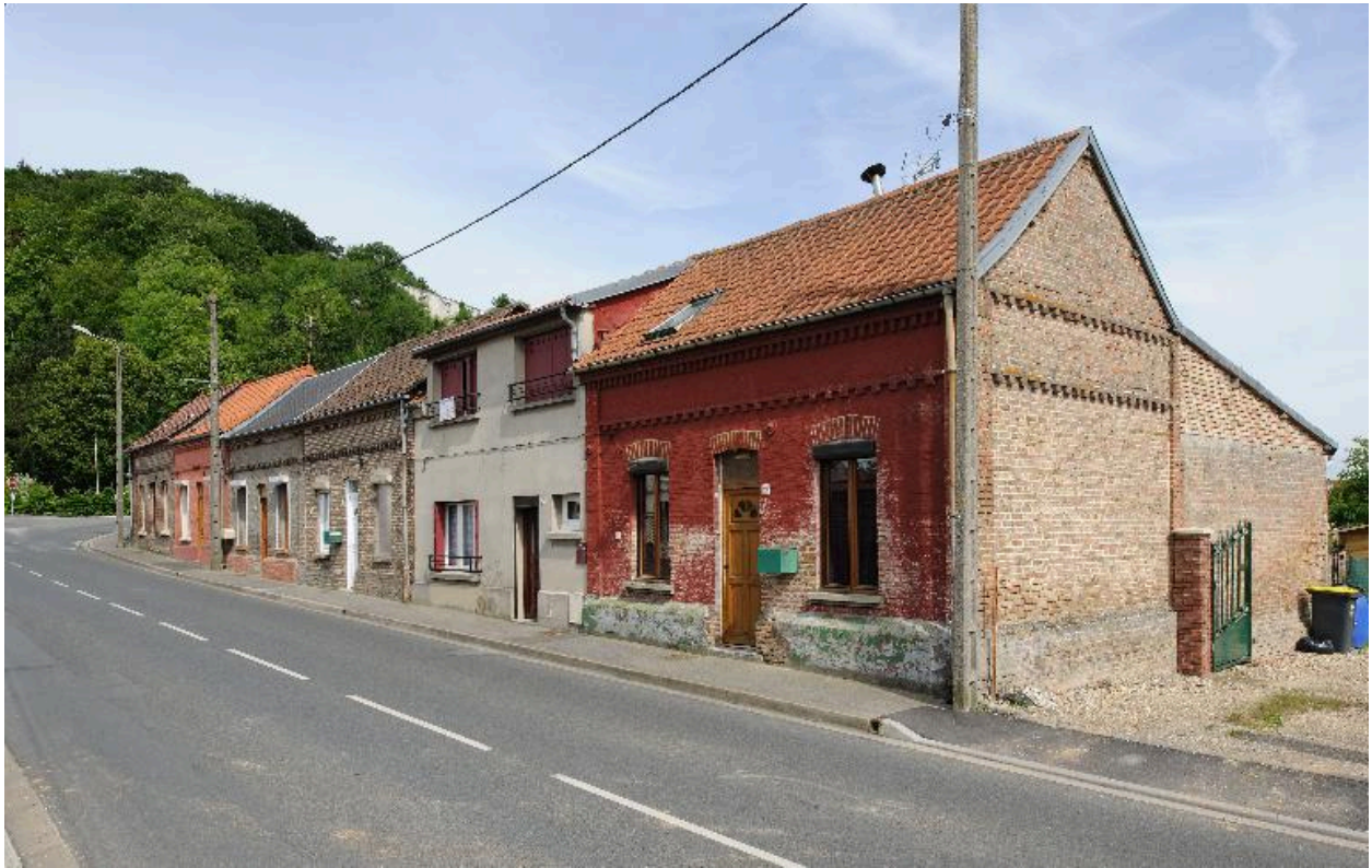
Vue d'ensemble sur rue.
