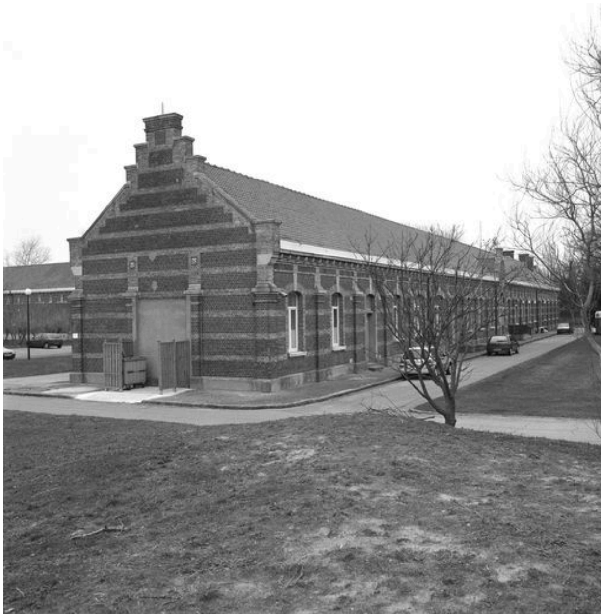
Pavillons des enfants valides, pavillon du groupe ouest abritant les bains-douches et les gymnases, élévation ouest, vue en enfilade prise du nord-ouest.
