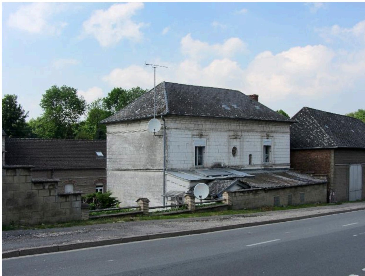
Façade postérieure donnant sur la route Nationale.
