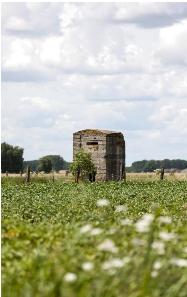
Vue générale vers le nord-ouest
