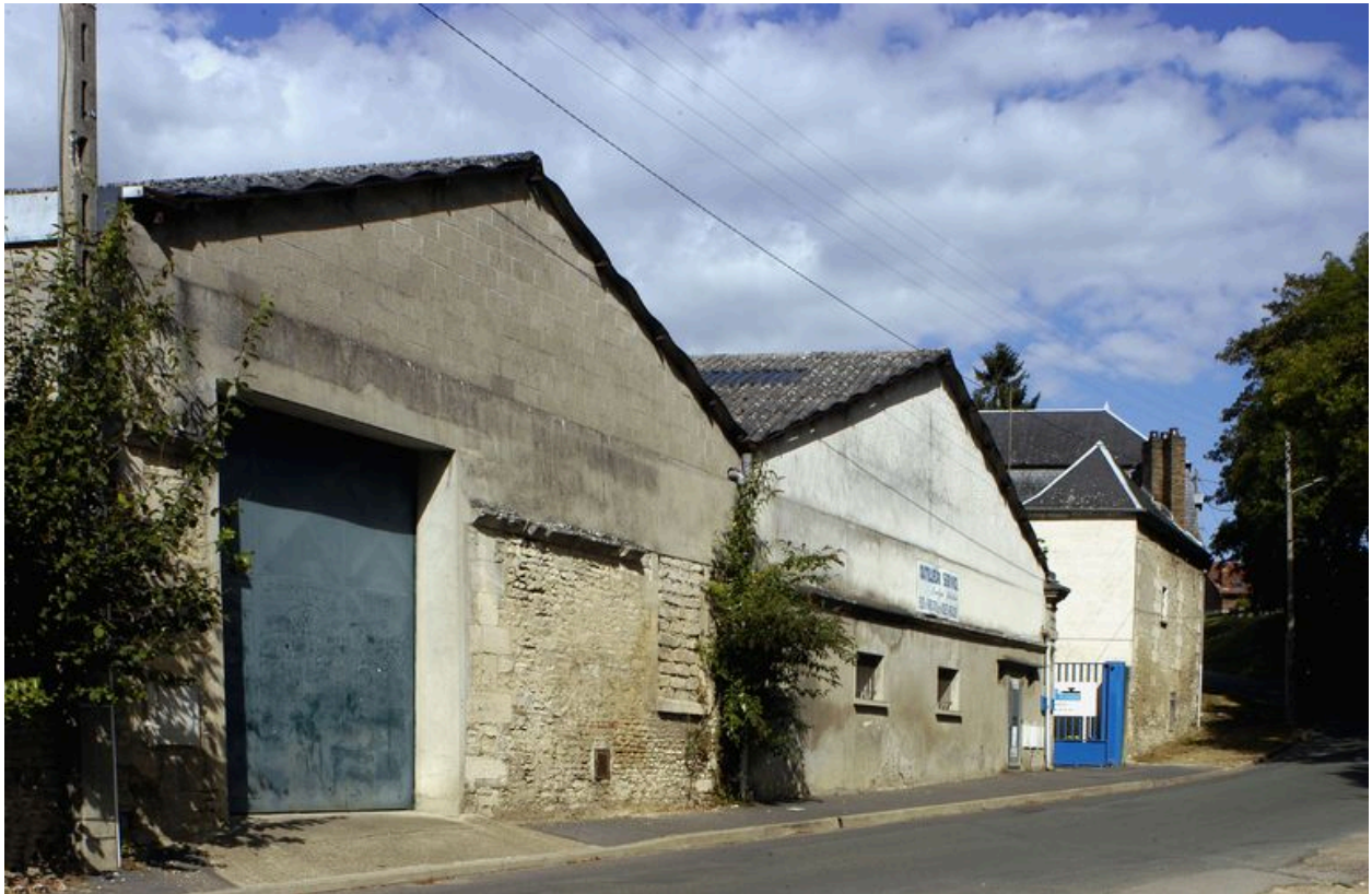
Vue des pignons sur rue des ateliers de fabrication.
