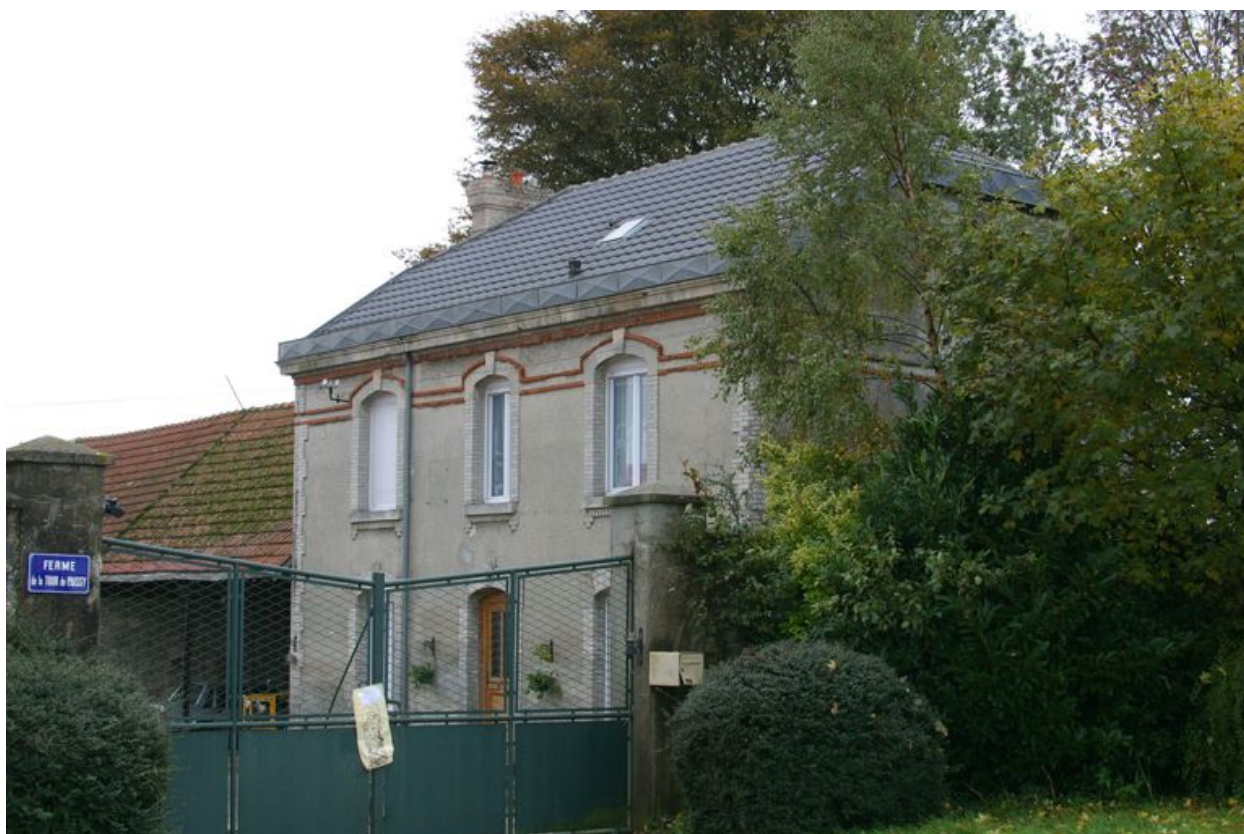
Vue de la façade principale du logis.
