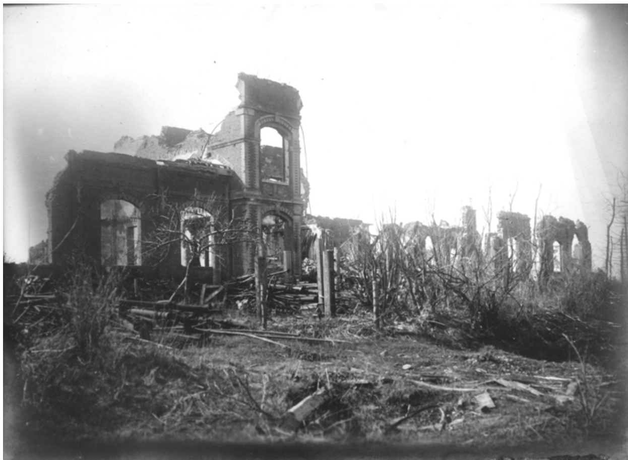
Façade antérieure de l'usine et des bureaux vers 1919 (AD Aisne).
