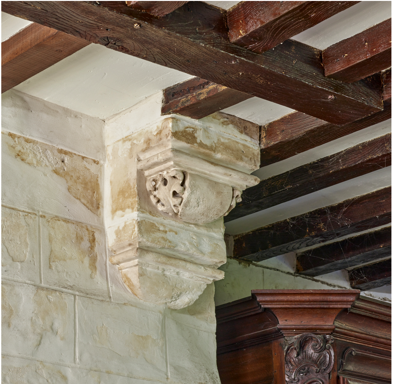
Détail d'un des corbeaux de la cheminée du manoir.
