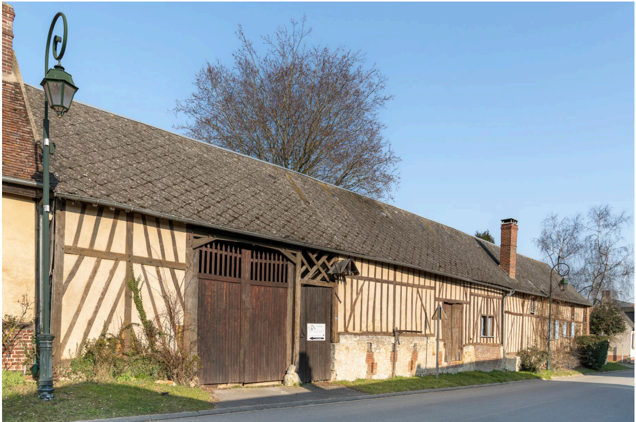
Bâtiments agricoles et entrée charretière, n°154 de la rue de Clermont, vue prise depuis le sud-ouest.
