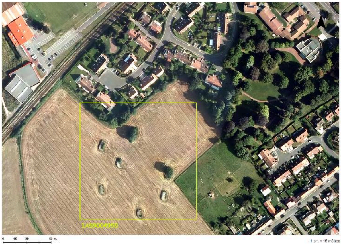
Situation de l'ensemble de casemate sur une photographie aérienne de 2014
