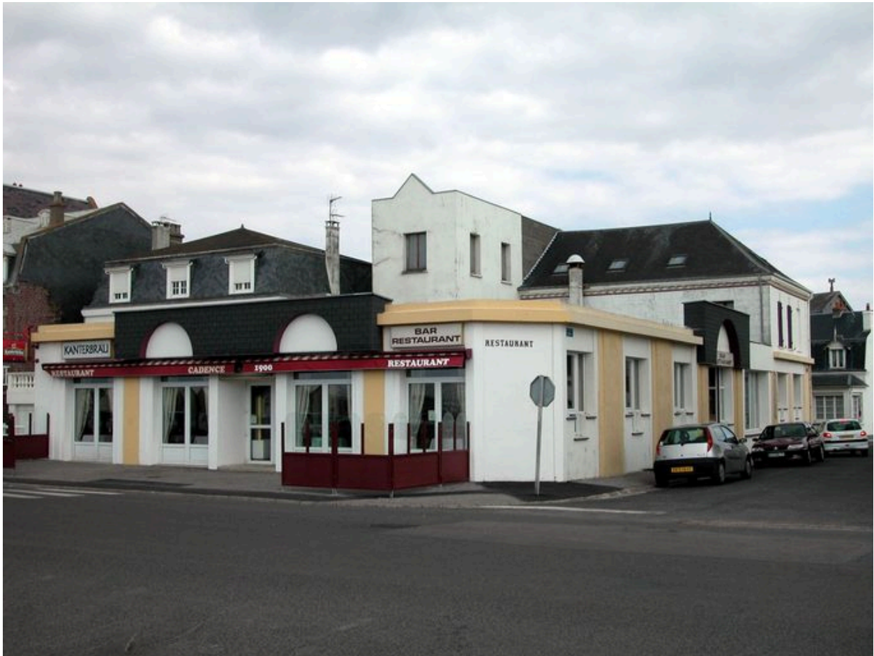
Vue d'ensemble depuis le front de mer.
