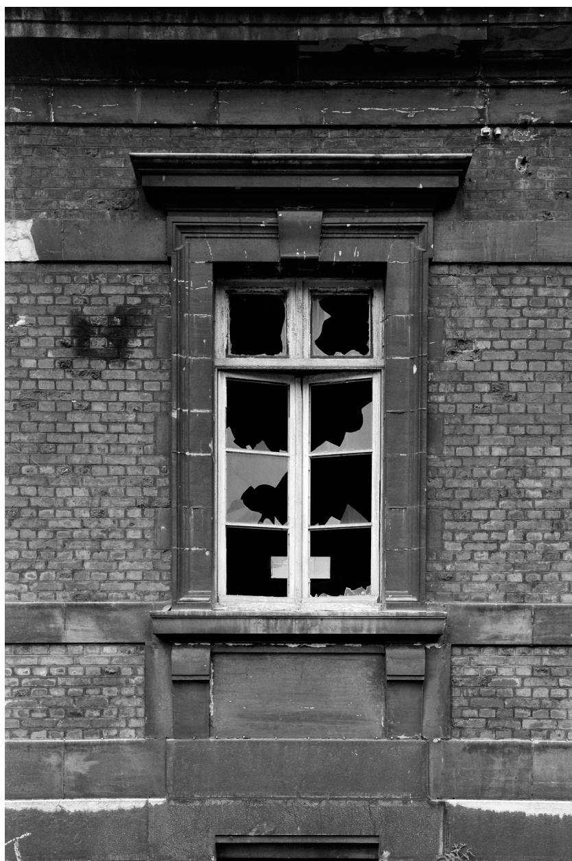
Bâtiment A, façade sur cour, fenêtres.
