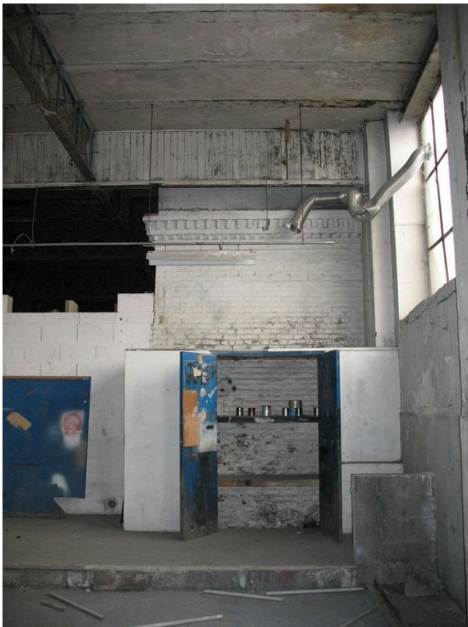
Détail de la base de la cheminée carrée en brique.
