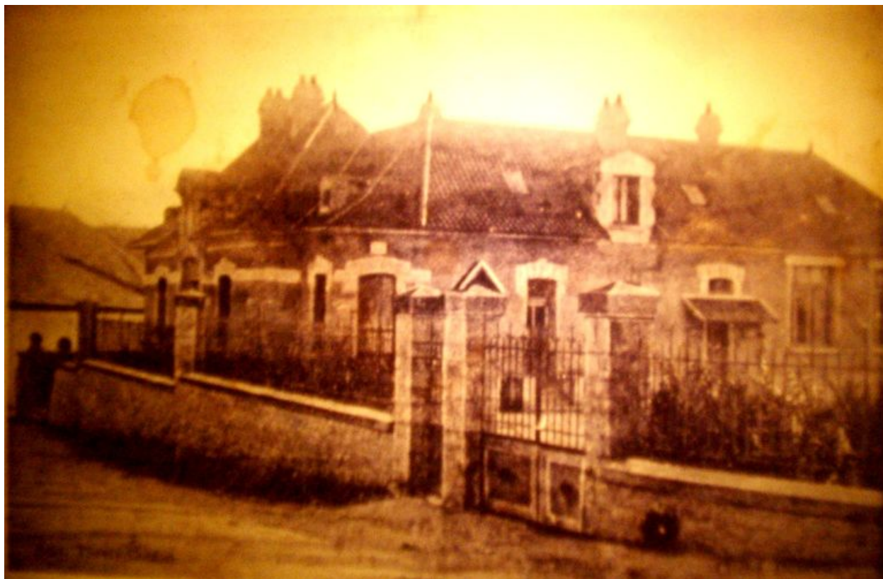
Vue ancienne des écoles (AD Aisne : 4 Fi 318).
