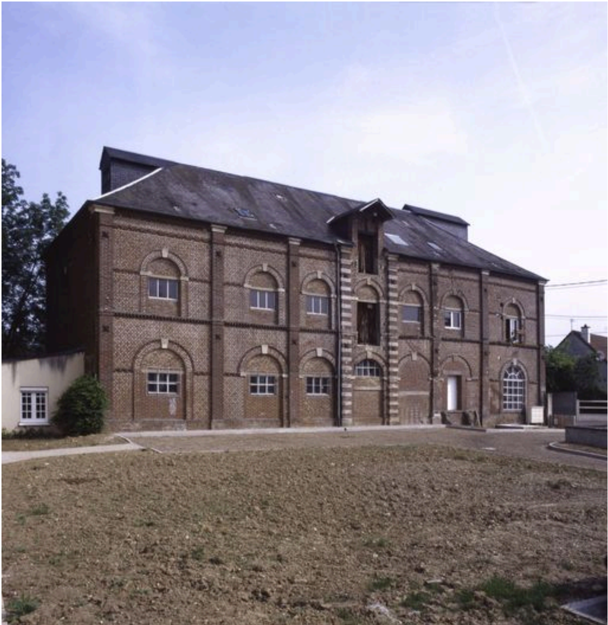
Vue d'ensemble sud-ouest de l'atelier de fabrication.
