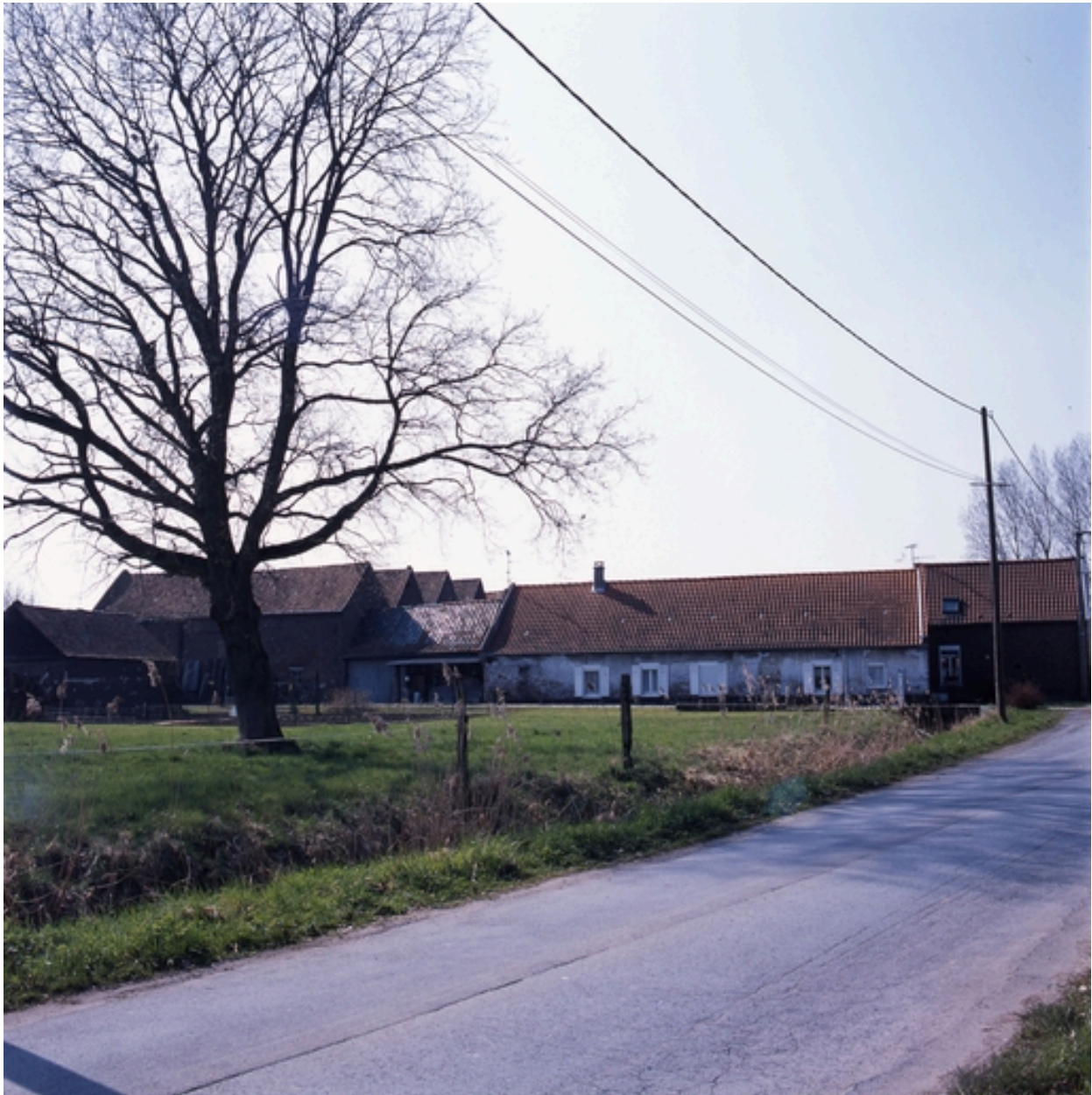
Vue générale de la ferme-usine.
