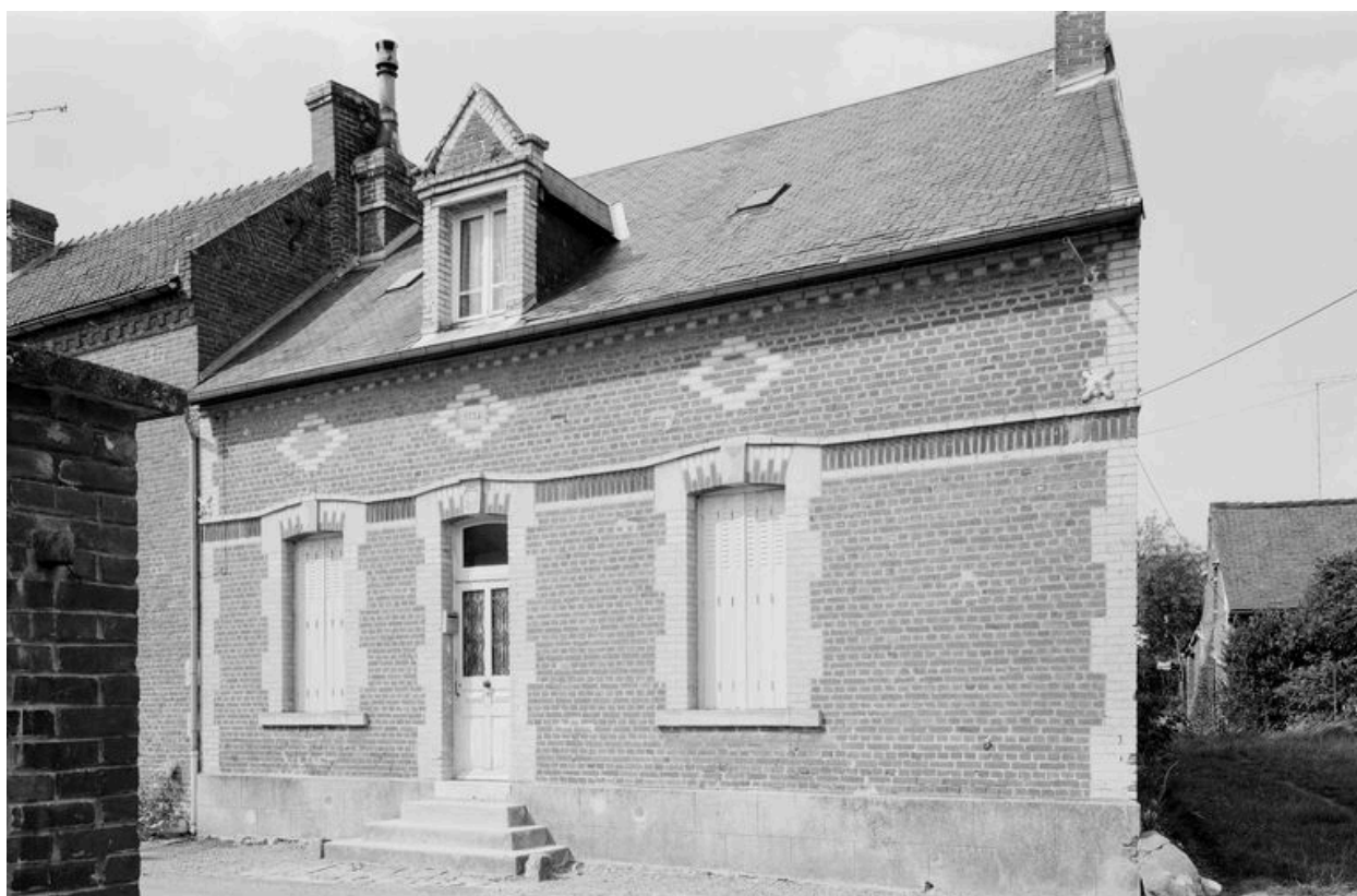
Maison repérée datée 1924. Élévation antérieure.
