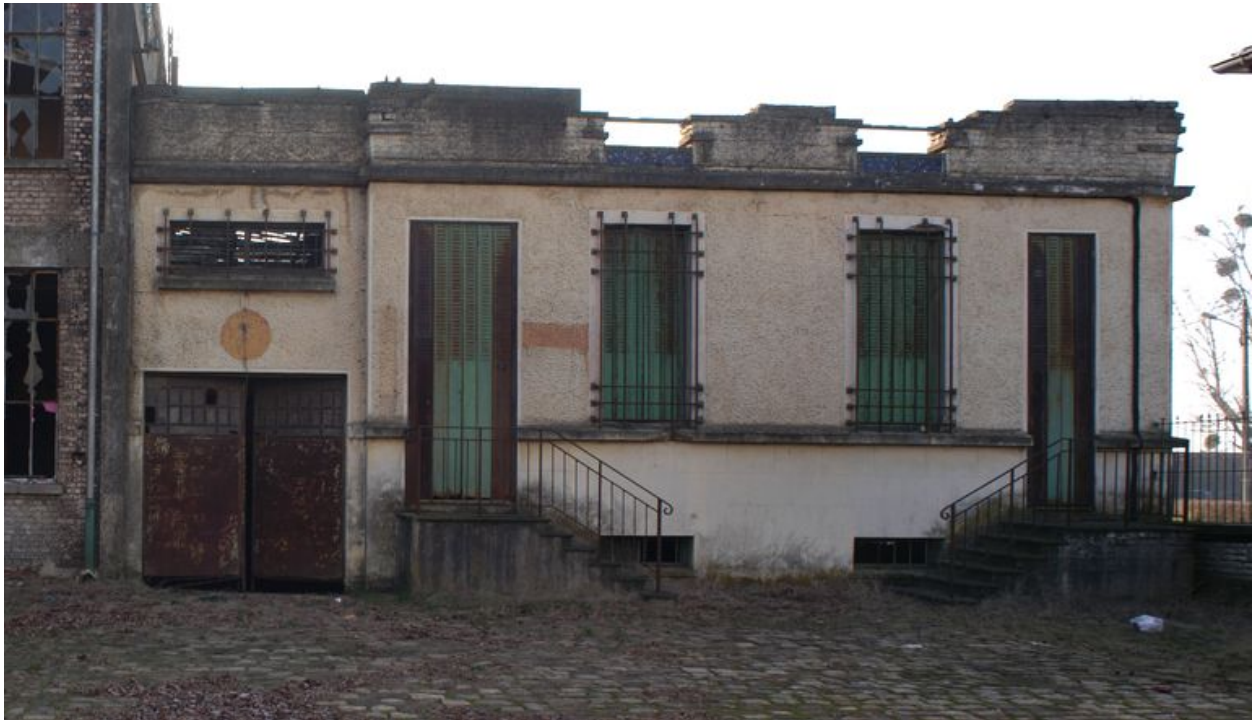
Façade sur cour des bureaux.
