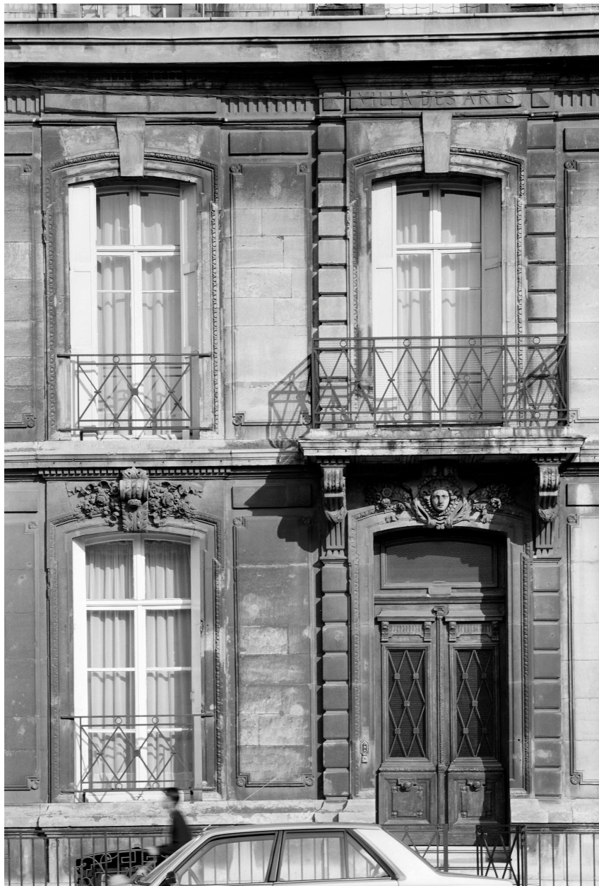
Façade sur voie, baies.
