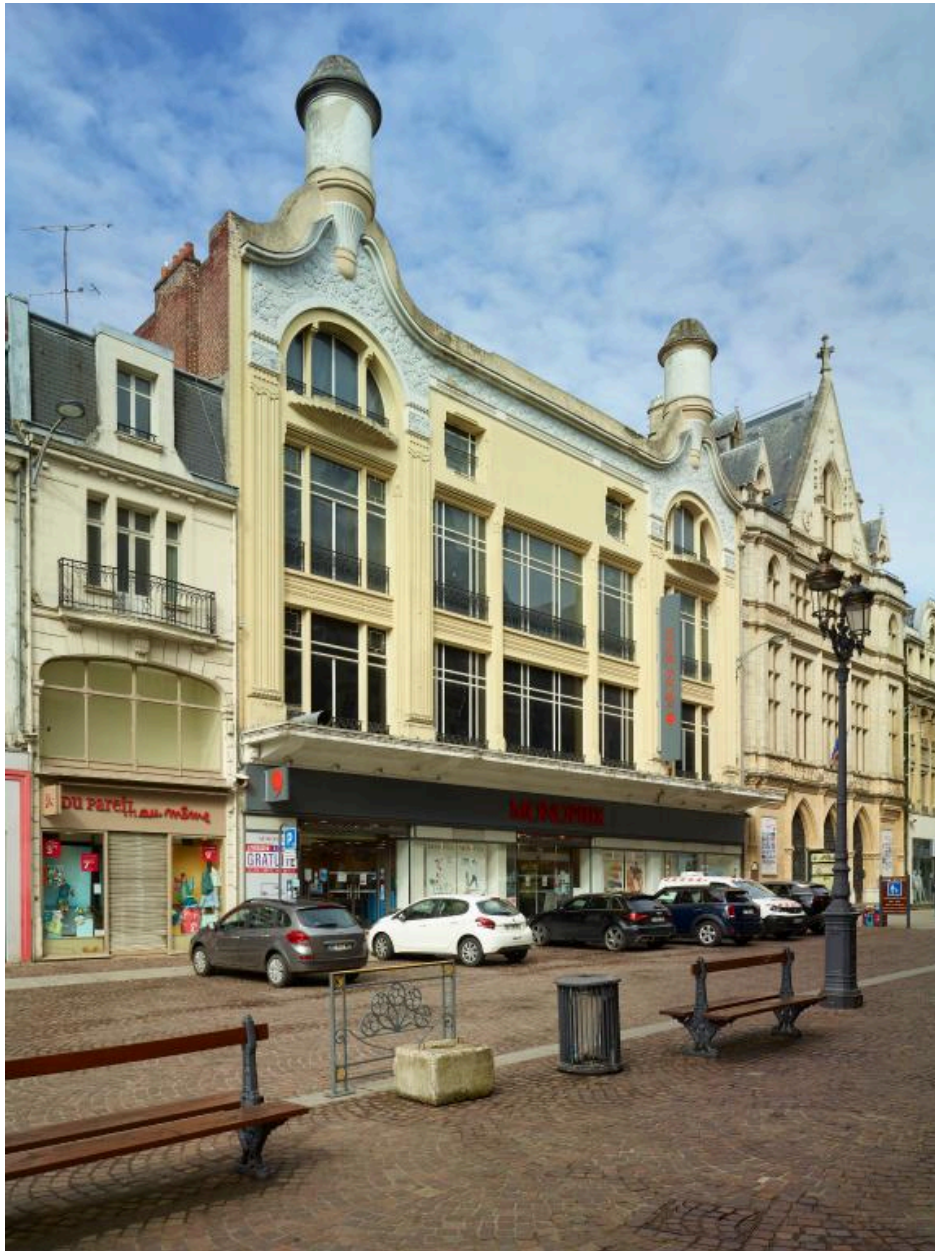
Façade principale donnant sur la rue de la Sellerie.
