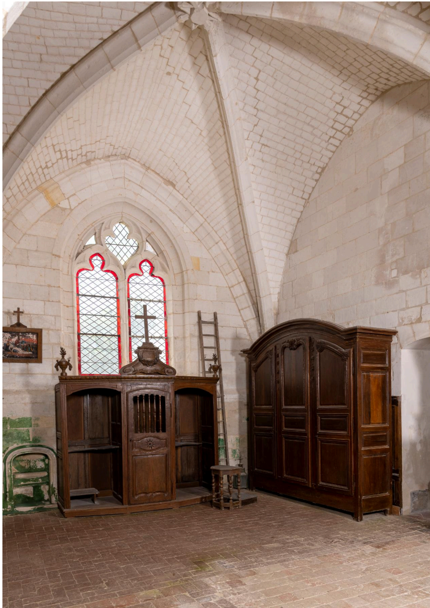
Vue générale de la première travée de la chapelle sud.
