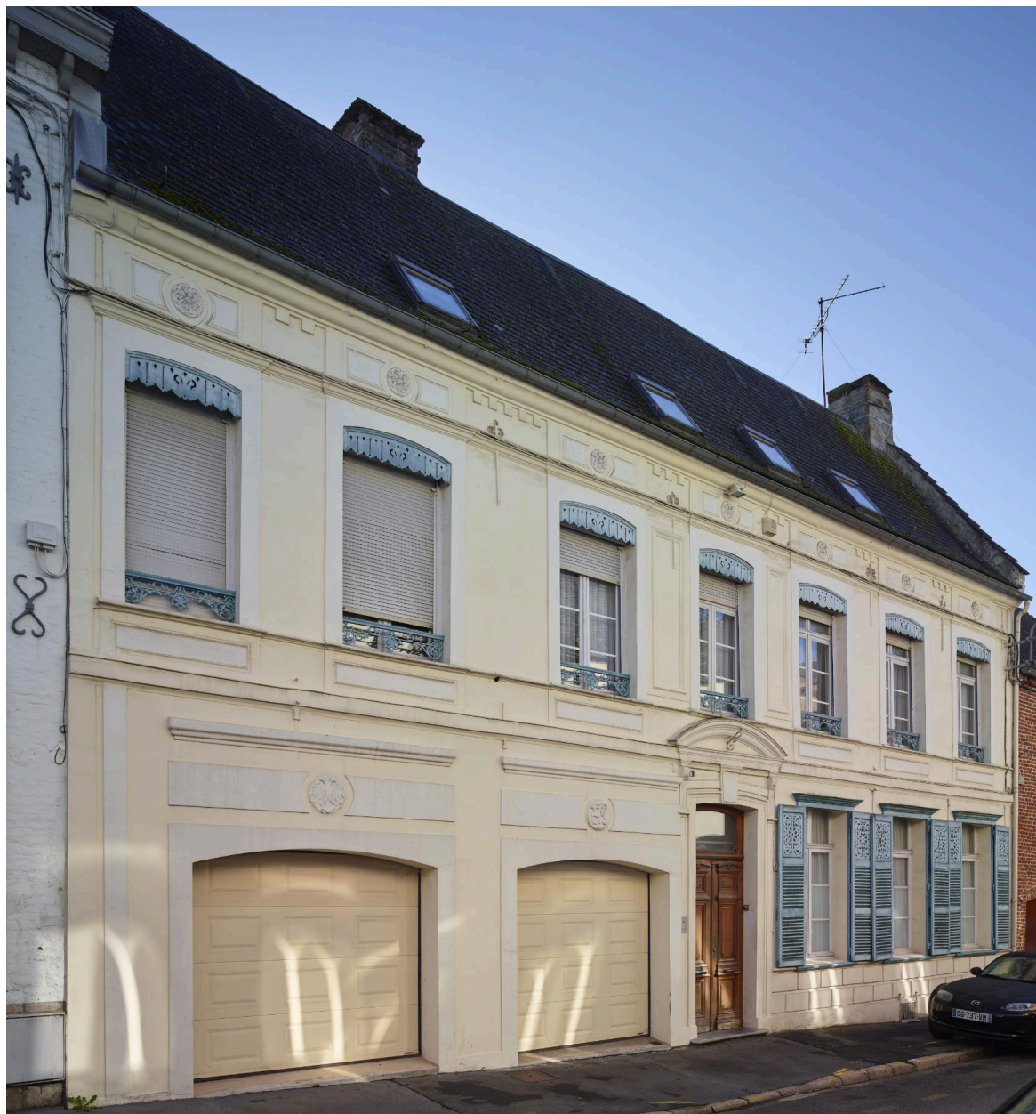
Maison de maître avec façade ordonnancée et porte soulignée - 9, rue Brancion.
