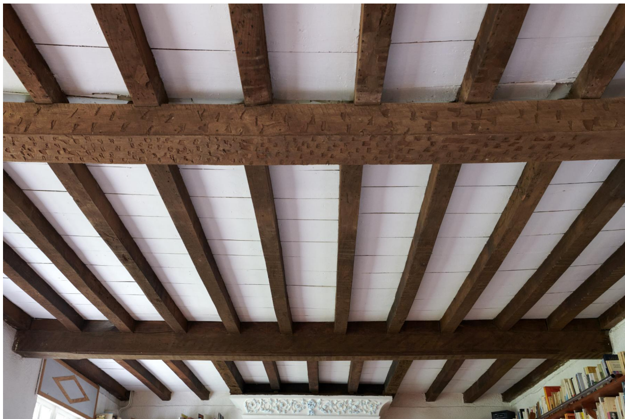
Détail des plafonds à la française du rez-de-chaussée de l'ancien presbytère.
