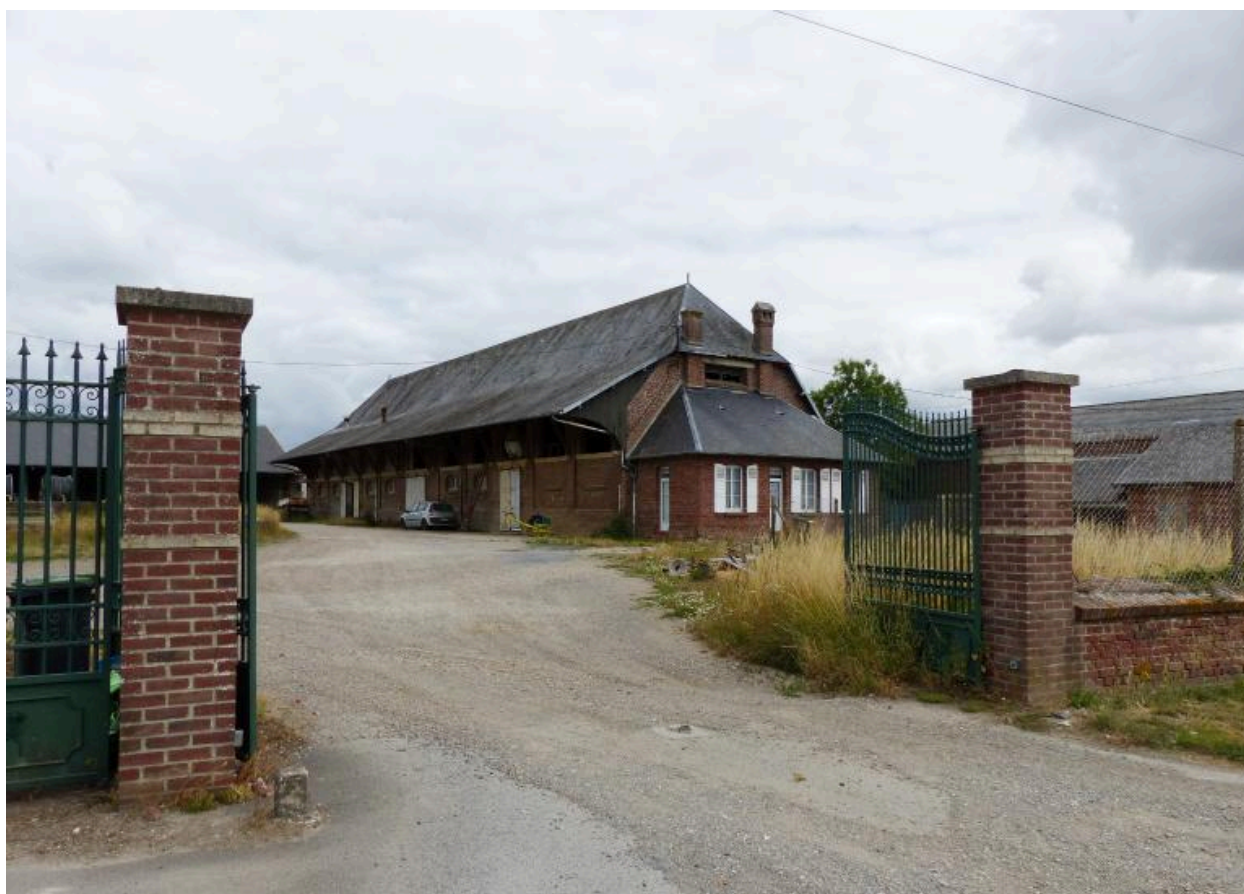
Vue des écuries et du logement de contremaitre.
