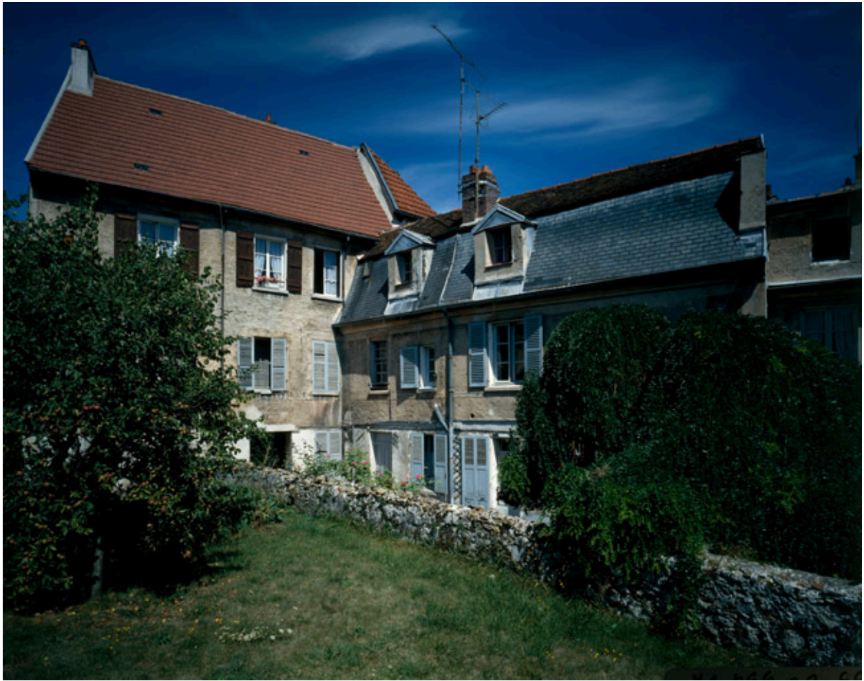
Vue d'ensemble sur la face arrière.
