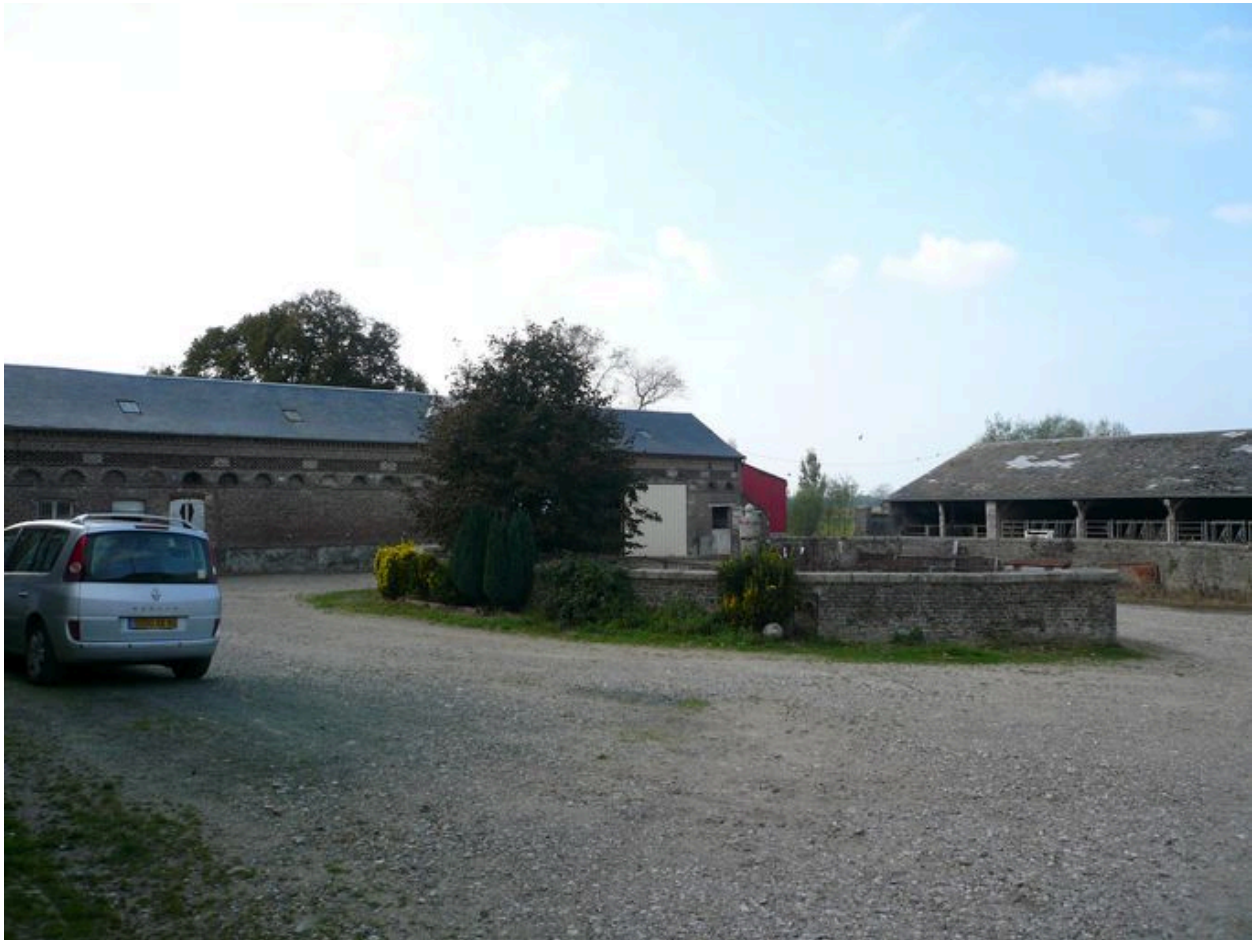
Vue des étables et du pédiluve au centre de la cour.
