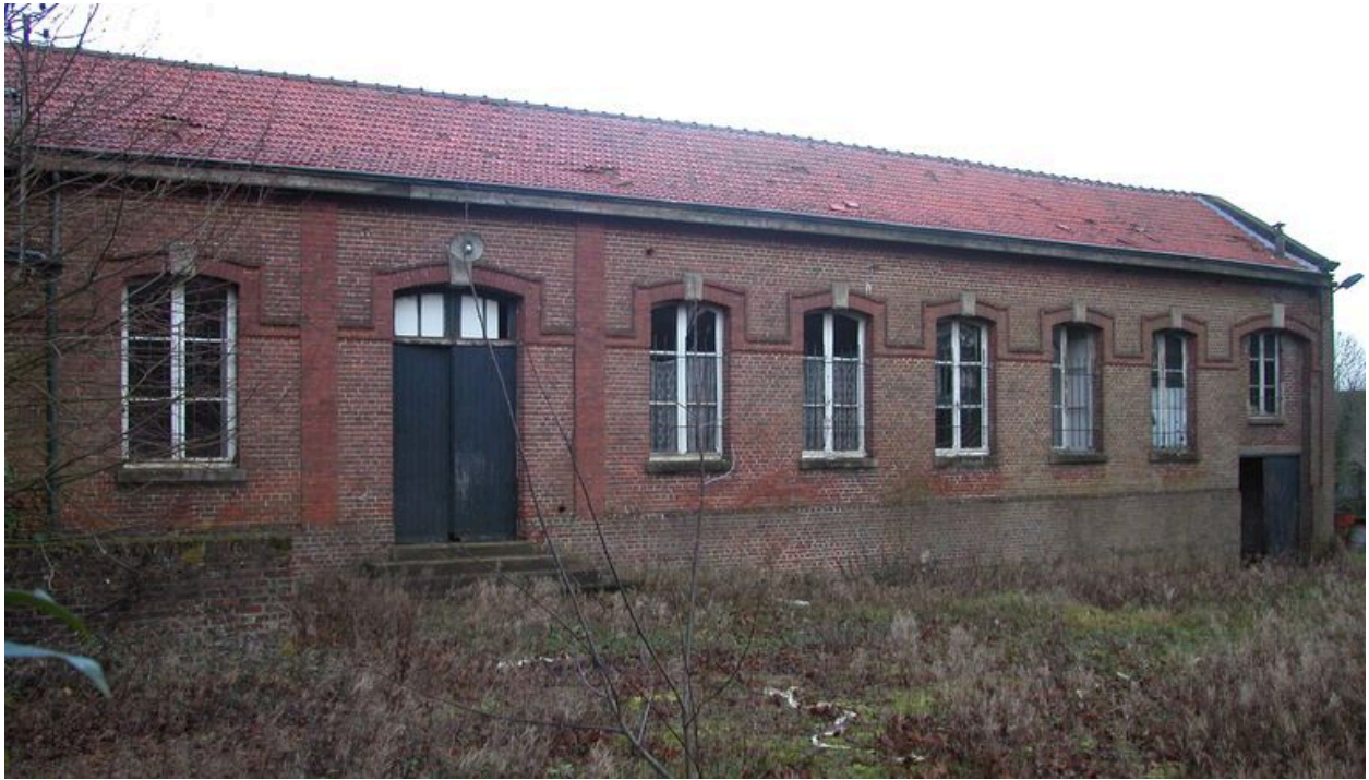
L'atelier d'entretien, façade sur cour.
