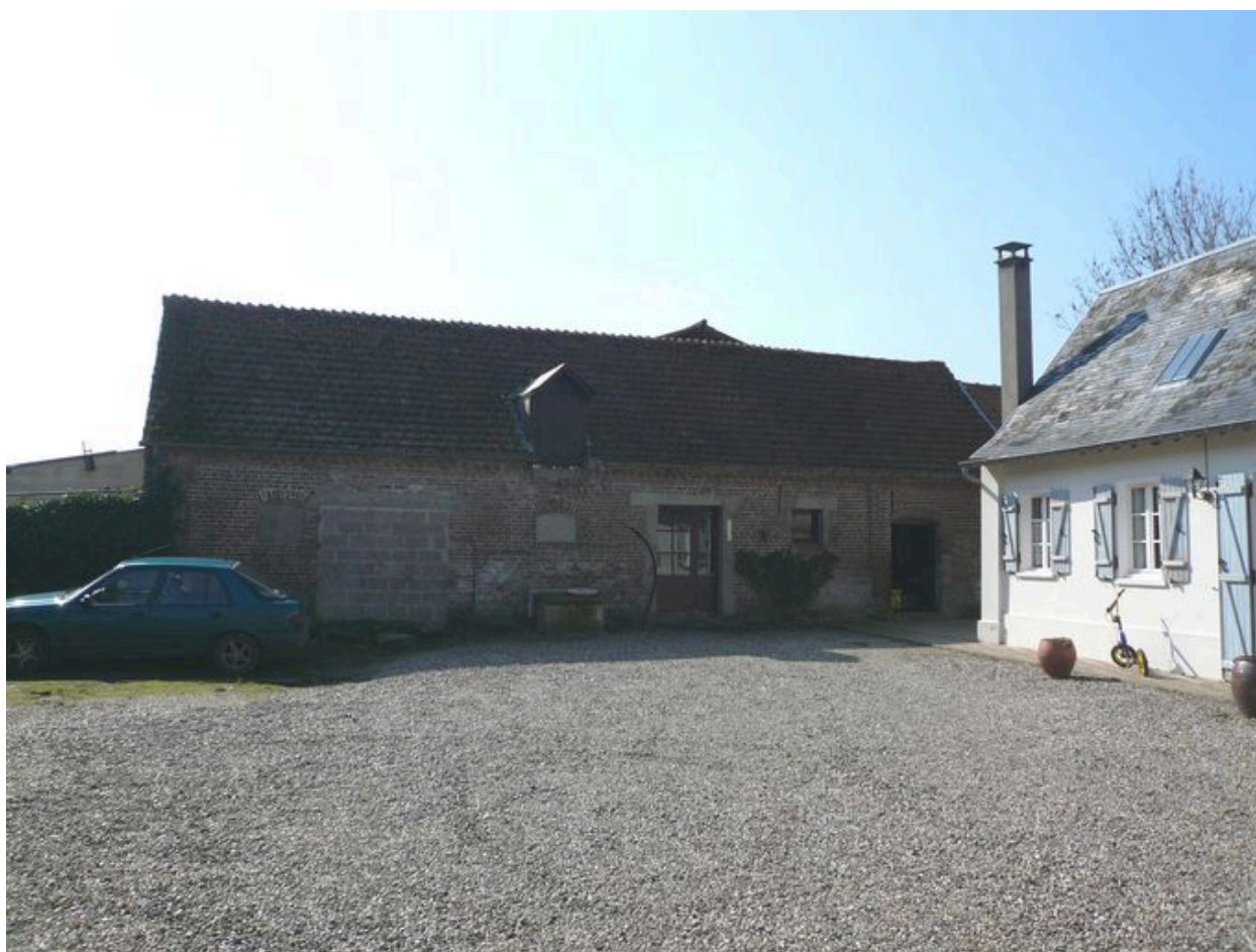
Vue des étables depuis la cour.
