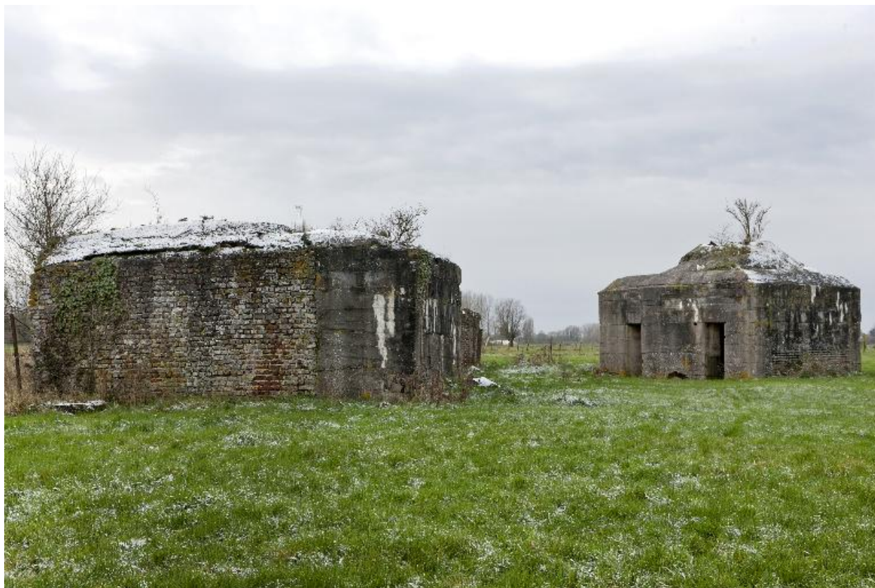
Les deux casmates, vues vers le sud-ouest.
