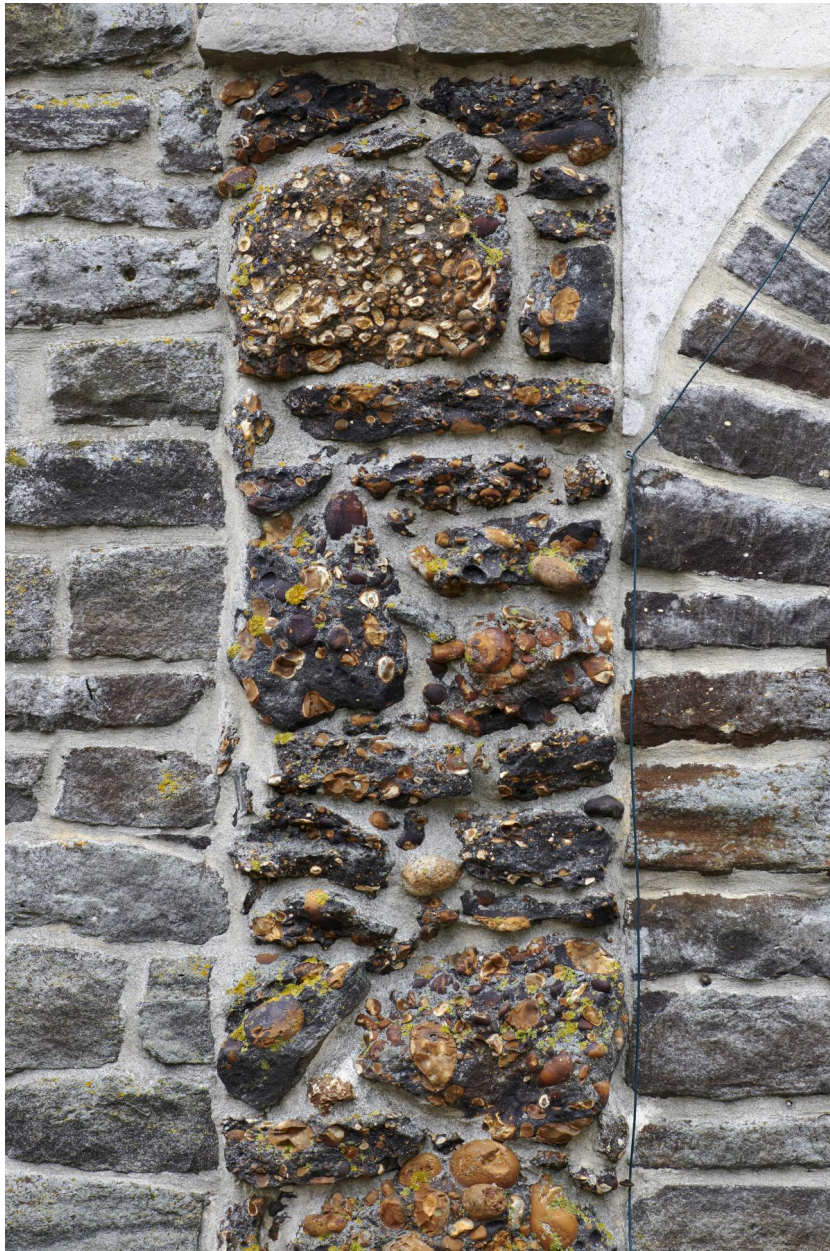
Détail des matériaux du pilastre et de la façade.
