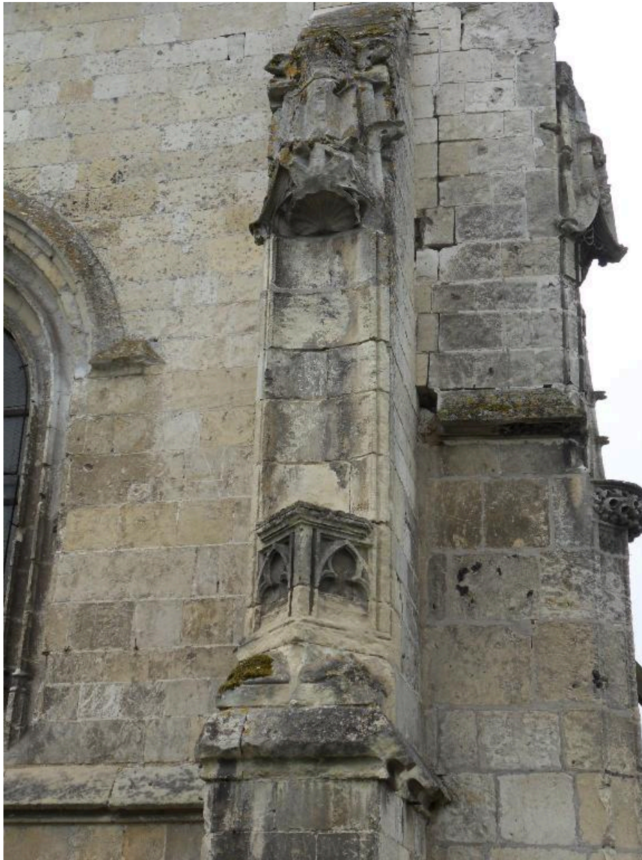
Détail sur le contrefort (angle nord-ouest)
