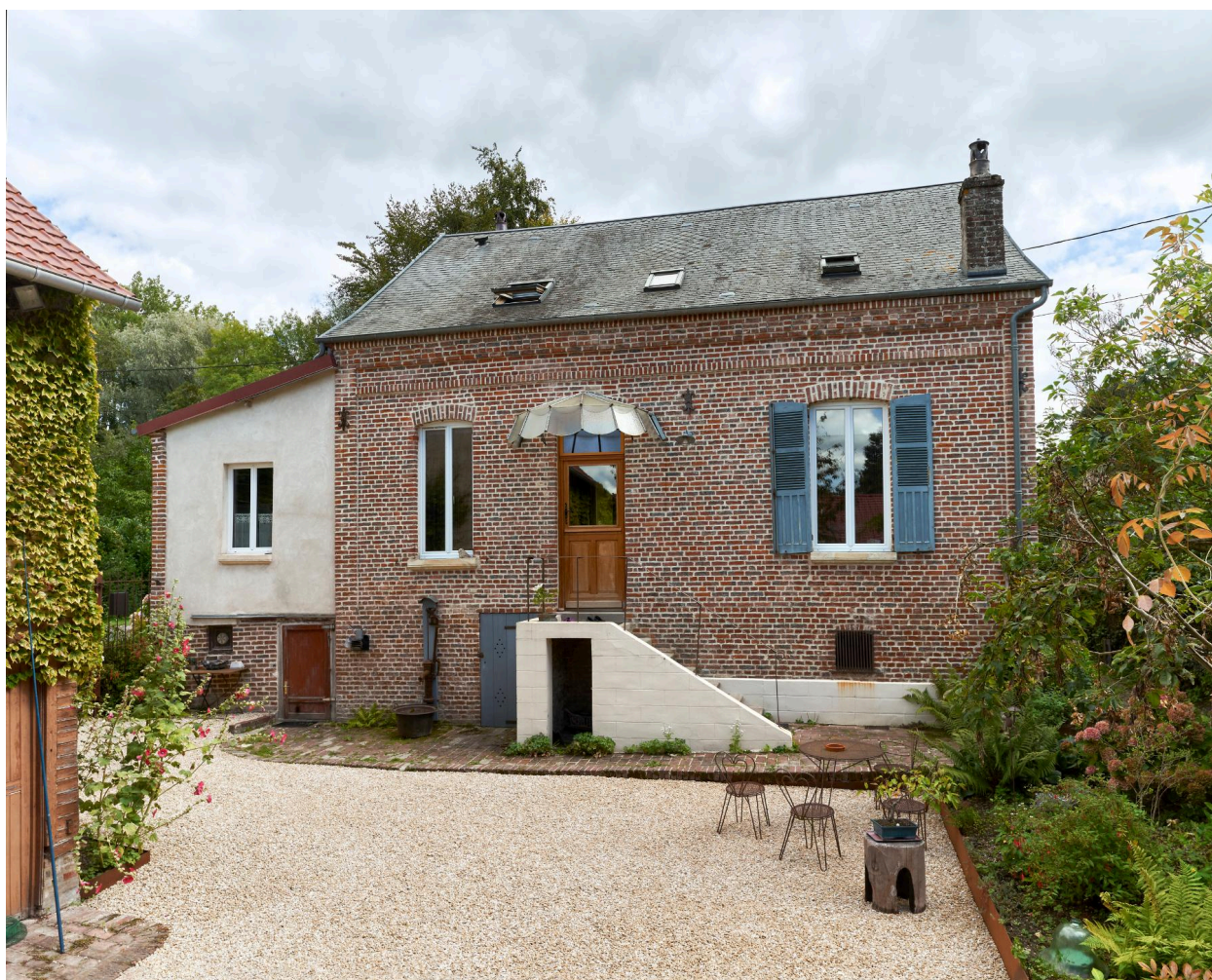
Maison d'habitation, vue prise depuis l'ouest.
