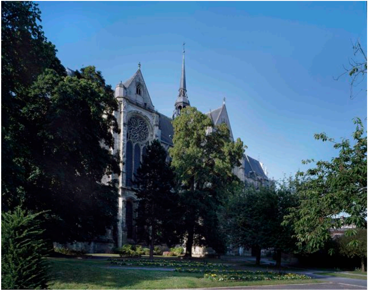
Vue de l'élévation nord.
