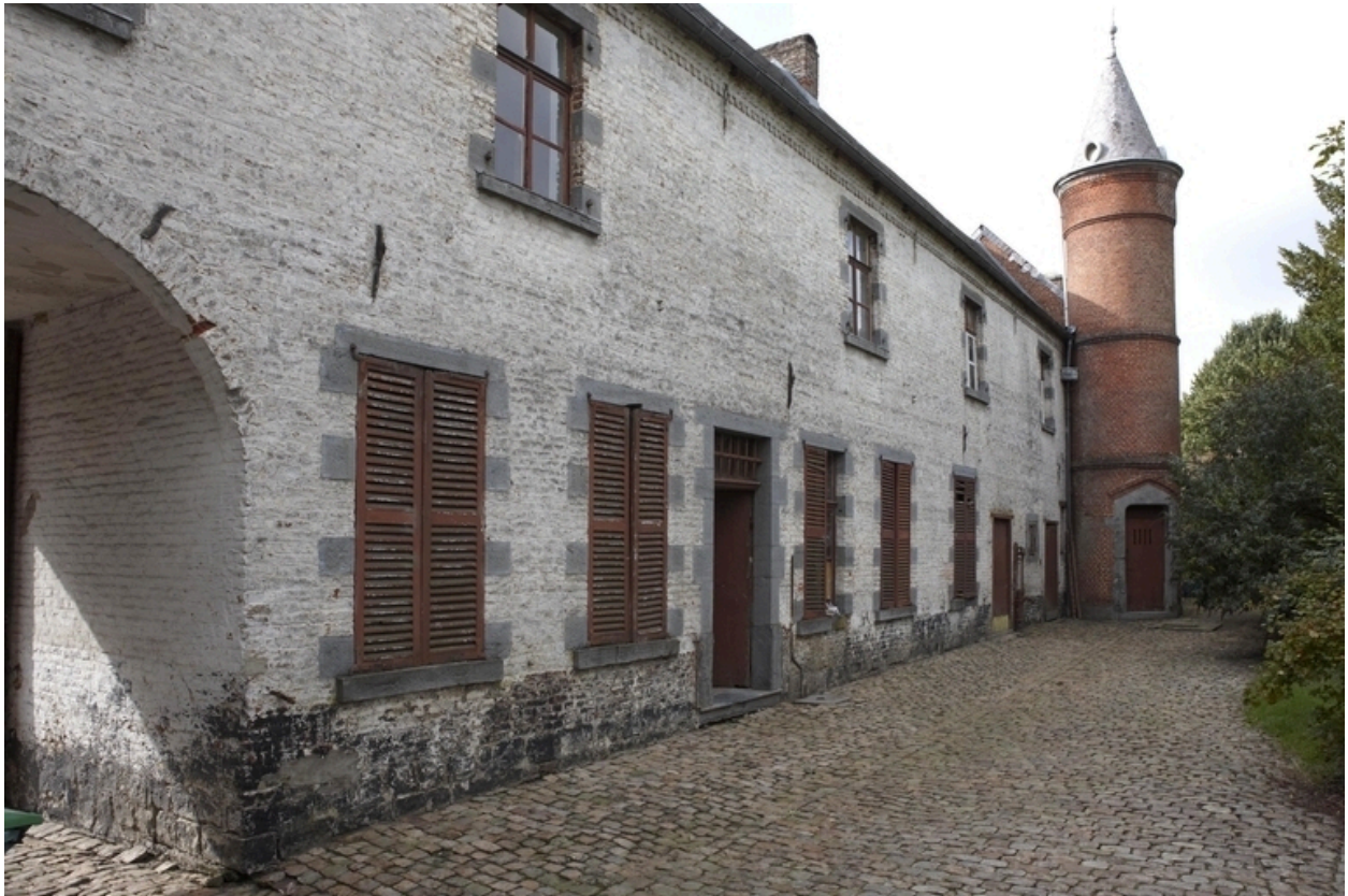
Vue de l'élévation sur cour du logis.
