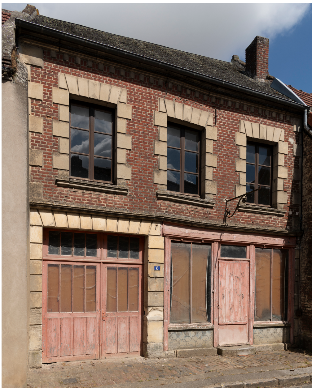
Ancien magasin de commerce, n°8 de la rue de la Halle, vue depuis le sud.
