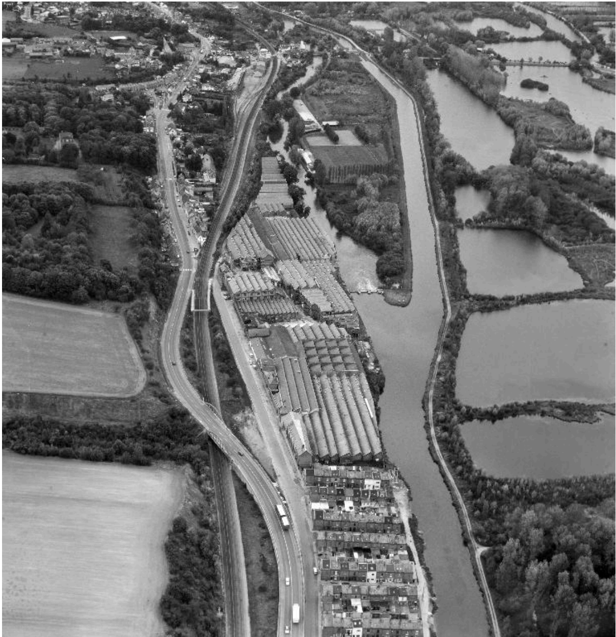
Vue aérienne, flanc sud-est.
