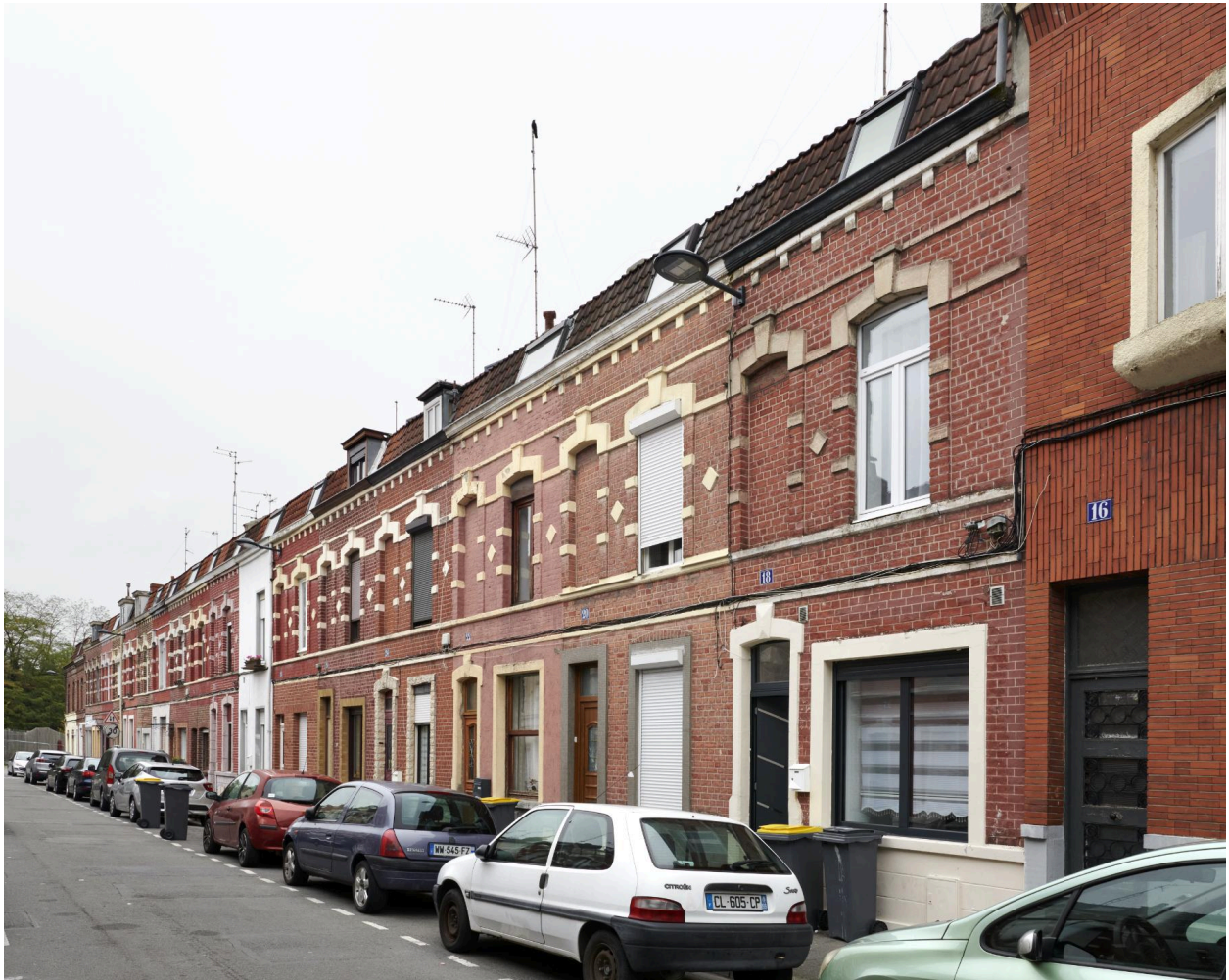
Vue générale du rang côté nord, n°18 à 50.
